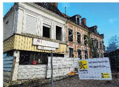
avant la démolition
