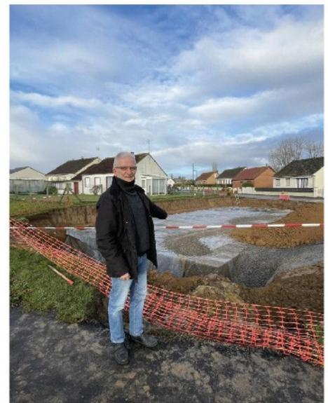
Pour éviter, lors de fortes précipitations, l'inondation du carrefour et de la route de Ham, un bassin d'infiltration a été réalisé sous espace vert avec le remplacement de la conduite des eaux pluviales.
